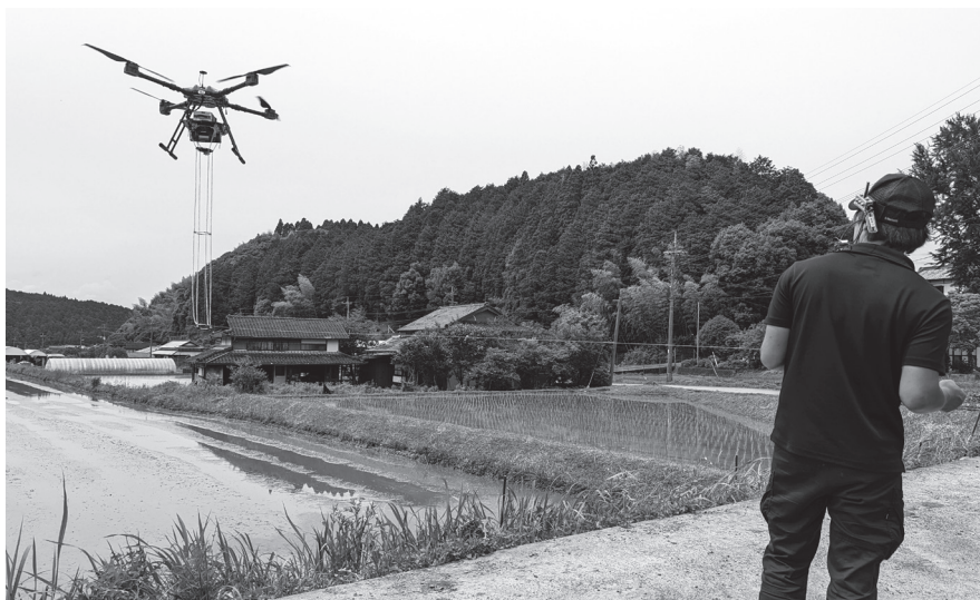
写真3 糸張りの様子
